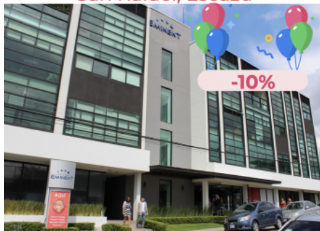
Oficina, Centro Corporativo San Rafael, Escazu
